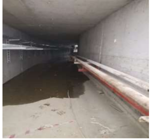
Boru Hatları imalat Montajı
